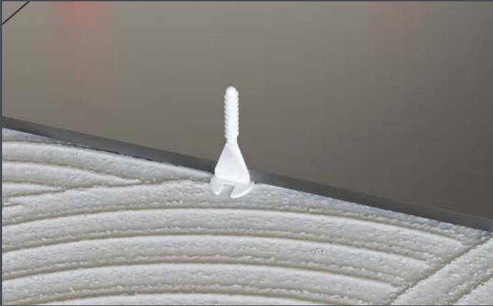
Vidalı Seviye Artısı Threaded Levelling Spacer
